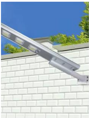
INSTALACIÓN EN MURO
